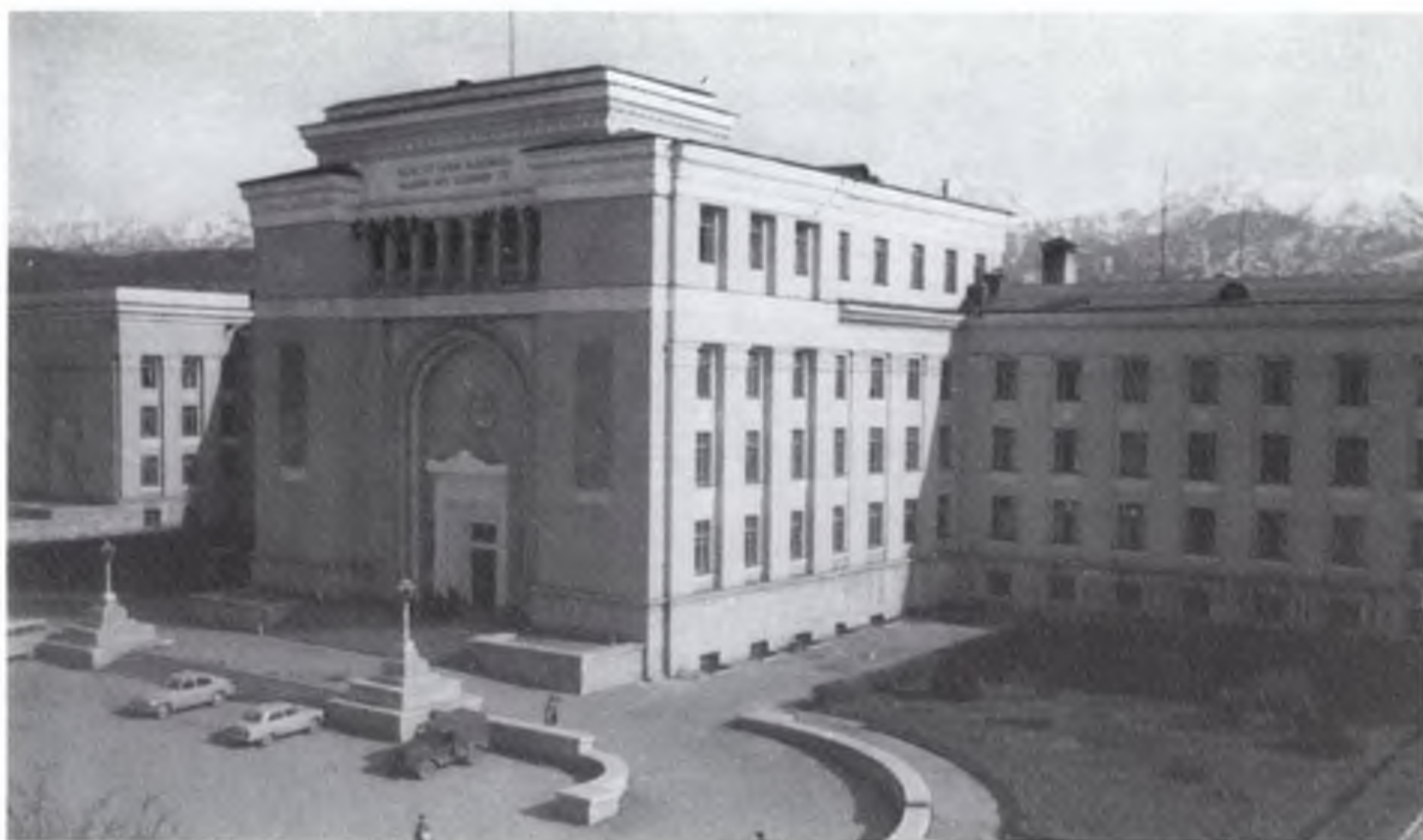
Здание Академии наук Казахстана. Строительство завершено летом 1957 г.
