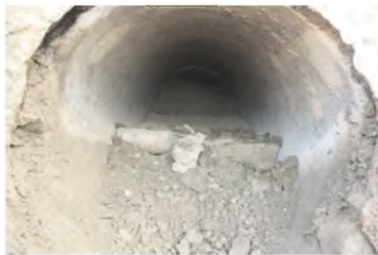
Рисунок 3 – Заилієння каналів і закупорка труб, ГТС на картових оросителях
