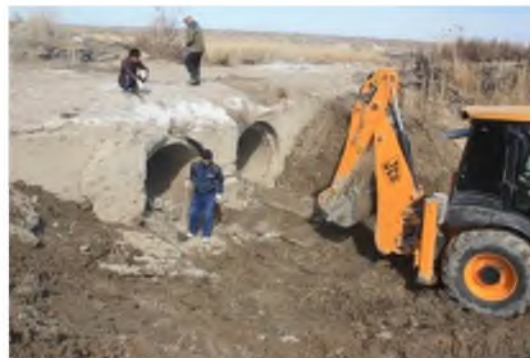
Рисунок 6 – Очистка картового оросителя
