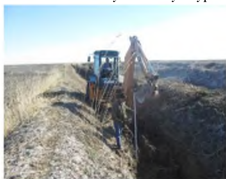
Рисунок 6 – Очистка картового оросителя
