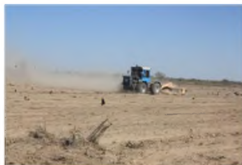
Рисунок 5 – Культурно-технические работы и планировка чеков
