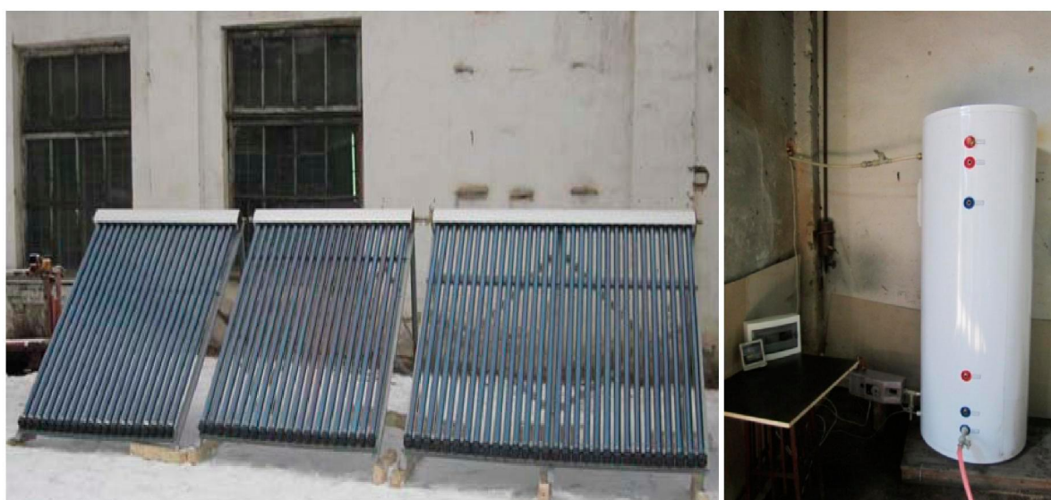
Рисунок 2 – Основные конструктивные элементы солнечного водонагревателя: а – гелиоколлектор; б – накопительный бак и пульт управления
