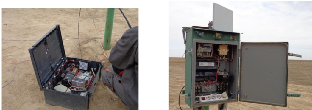
Рисунок 2.5 – Шкаф управления включающий контроллеры Fatek, ОВЕН МЭ110 и модули МОХА беспроводной передачи данных.
