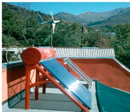
Рисунок 4 - Солнечные вакуумный водонагреватель, фотопреобразователи и ветрогенератор.
