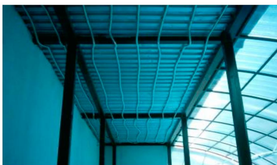
Рисунок 5 - Потолочный теплообменник рекуперации тепла.
