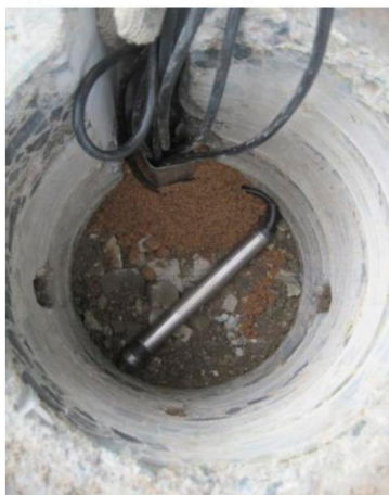
Рисунок 10. Закладка датчика в дорожную конструкцию
