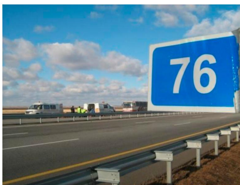
Рисунок 8. Общий вид участка (км 76+030) автомобильной дороги «Астана-Бурабай»
