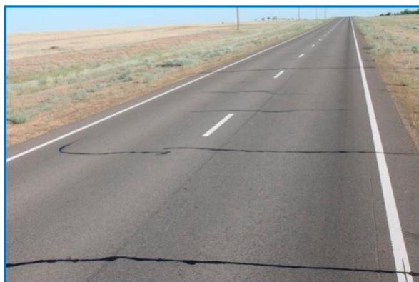
Рисунок 1. Низкотемпературное растрескивание асфальтобетонного покрытия автомобильной дороги
