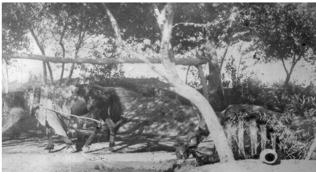
8-сурет – Ат шығыр (шығырды ат көмегімен қозғалысқа келтіру). XIX ғ. аяғы. Қазақстан Республикасы Орталық мемлекеттік кинофотоқұжаттар және дыбыс жазбалар мұрағатынан
