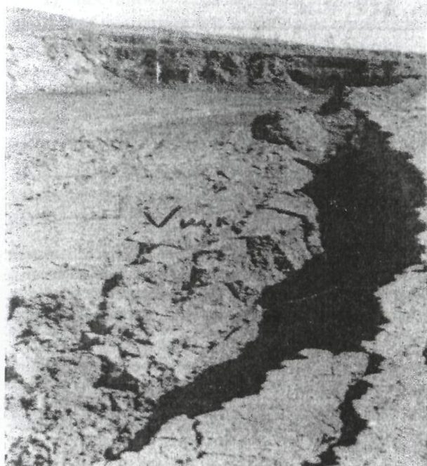
Рис. 4. Трещины бортового отпора приводят к формированию оползня в лежачем борту карьера Центральный, блок 3 (фото Т. Л. Тесленко, 1979)
