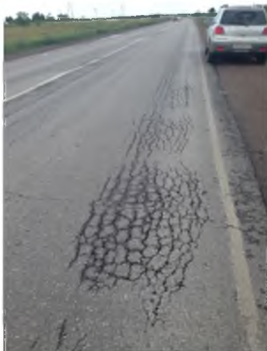
Рисунок 2 – Усталостная деструкция асфальтобетонного покрытия автомобильной дороги «Караганды-Шахтинск» (июль, 2016 год)
