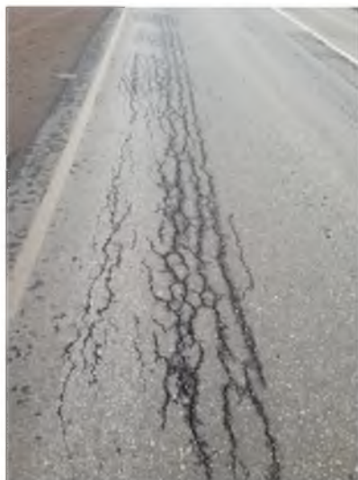
Рисунок 2 – Усталостная деструкция асфальтобетонного покрытия автомобильной дороги «Караганды-Шахтинск» (июль, 2016 год)
