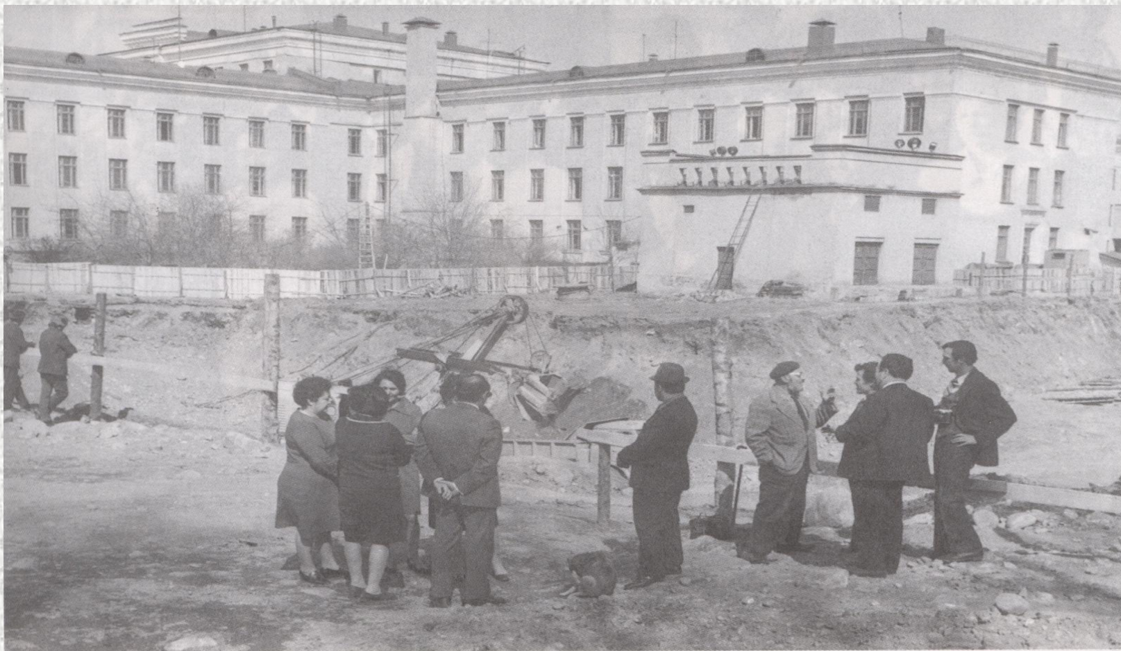
На месте будущего книгохранилища, 1976 г.
