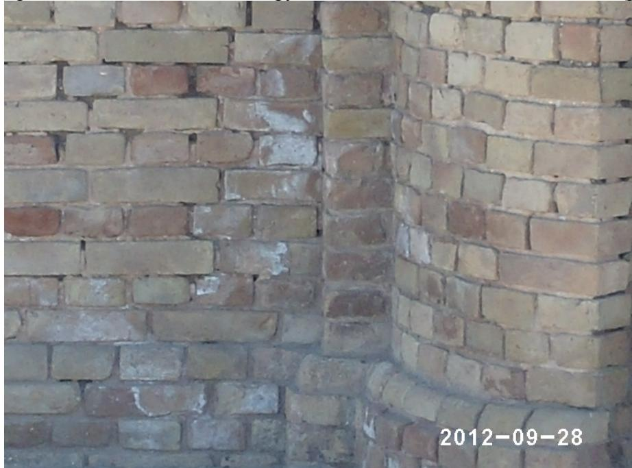
Рисунок 5 – Сыростные пятна на стенах и фундаментах мавзолея Арыстанбаб
