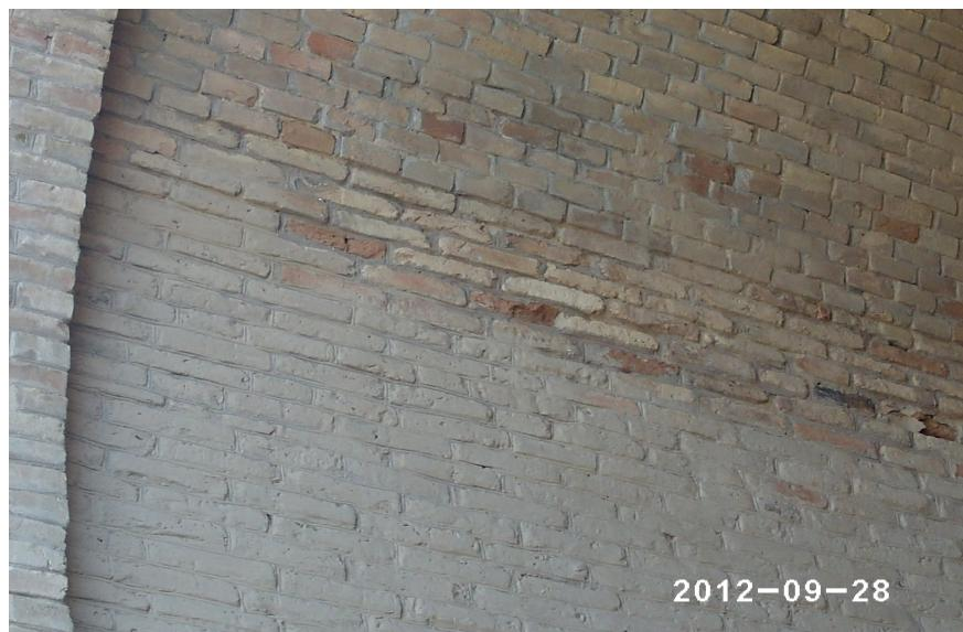
Рисунок 2 – Разрушение кирпичной кладки мавзолея Арыстанбаба
